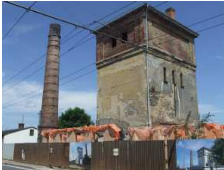
Současný stav vodárny při pohledu z ulice.
