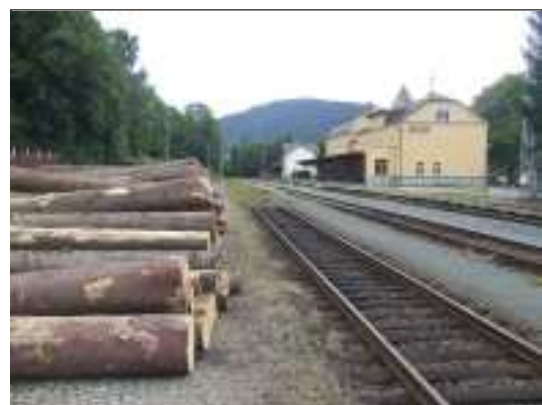
Současná nevyhovující nástupiště budou nahrazena novými s výškou hrany 550 mm nad temenem kolejnice, s jejich zastřešením se ale nepočítá.
