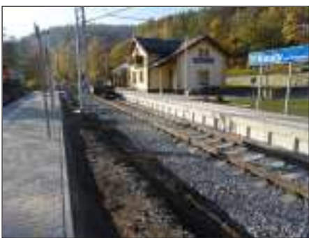
Konečná železniční stanice Kouty nad Desnou těsně před dokončením elektrizace.
