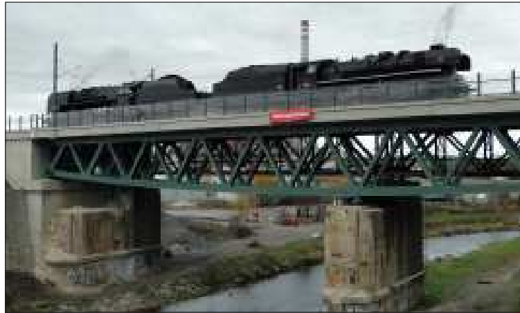
Na snímku zatěžkávací zkouška mostu přes řeku Úslavu za asistence parních lokomotiv.
