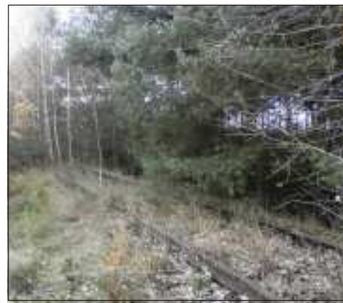
Z vyloučené lokální trati Mladotice – Kralovice dnes bohužel bylo torzo zarostlé náletovými dřevinami.
