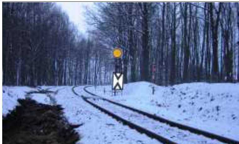
Jediná plně funkční předvěst na trati Vrané–Dobříš u Mníšku PFL; vlevo–kabelizace nové technologie je v plném proudu i v zimě, stav 7. 1. 2016.
