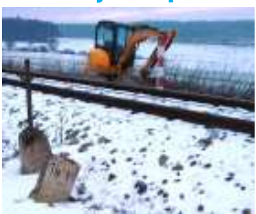
Bagřík kabelizace u tratě v km 14,1, snímek ze 7. 1. 2016.
