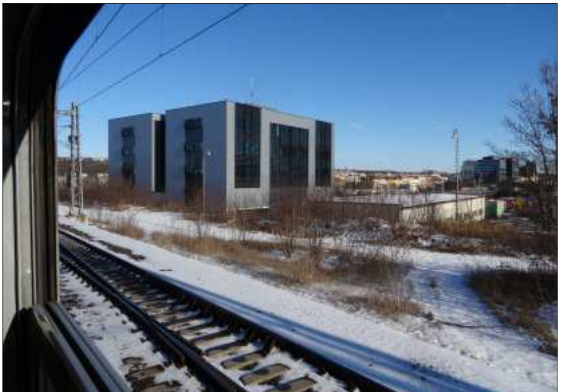
Pětipodlažní budova CDP Praha stojí na Balabence, v trianglu tratí Praha-Libeň-Praha hl. n., Praha-Libeň-Praha-Holešovice a Praha hl. n.-Praha-Vysočany. Snímek Michael Mareš
