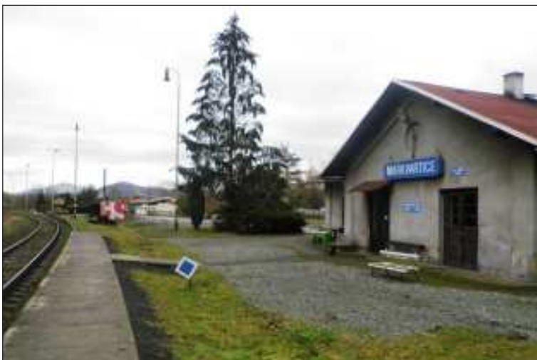
V rámci rekonstrukce traťového úseku Benešov nad Ploučnicí – Česká Kamenice se nácestná zastávka na znamení s hláskou Markvartice změní na železniční stanici se dvěma bezbariérovými nástupišti o délce 100 m.
