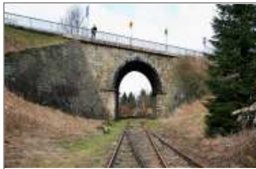
Pod kamenným viaduktem na Moldavě končí od května 1945 koleje. Na mostě prochází státní hranice se SRN.
