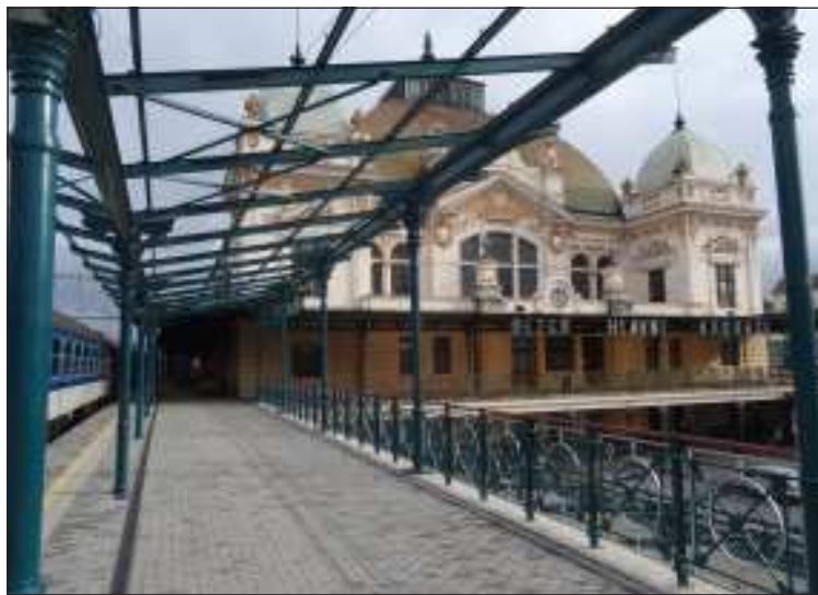
Hlavní nádraží v Plzni žije v těchto dnech stavebními pracemi. Na snímku nástupiště č. 3, západní část, během rekonstrukce a před dokončením zastřešení.
