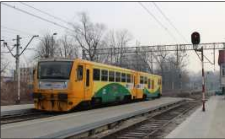
Ve stanici Cieszyn s návratem vlaků došlo i na výstavbu nových nástupišť.
