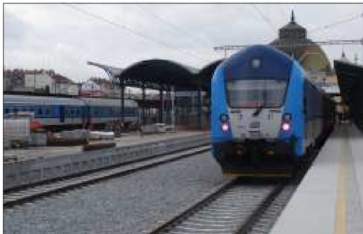
Dokončovací práce na 3. (vpravo) a 4. nástupišti, východní část, v blízkosti budoucího východního podchodu. Na snímku končí osobní vlak z Berouna.
