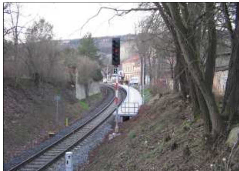
Vjezdové návěstidlo L dálkově řízené Výhybny Prokopské údolí stojí těsně před novou zastávkou.
