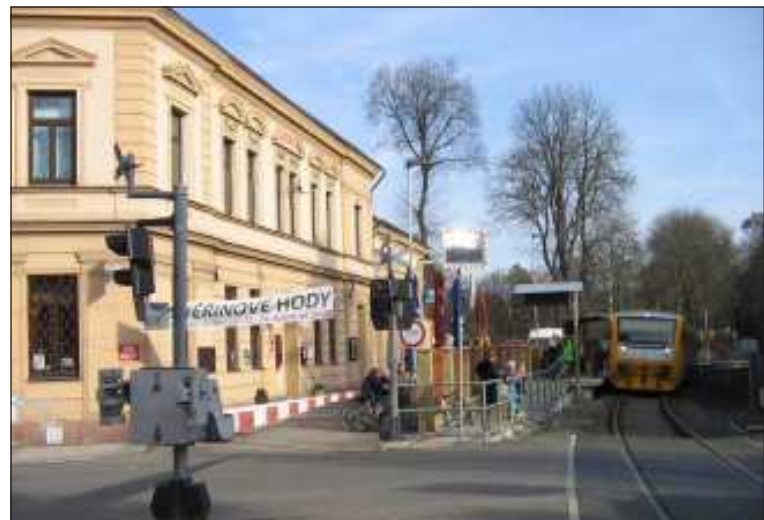
Nová zastávka Praha–Hlubočepy leží v oblouku (!) v km 3,485. Stav 27. března, vlak Os 19916 relace Praha–Smíchov – Beroun.
