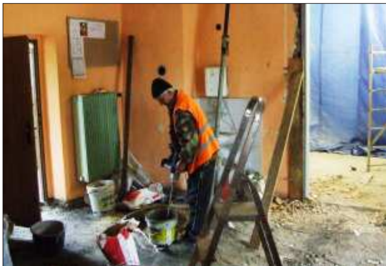
Dopravní kancelář v Rudě nad Moravou prochází přestavbou na technologickou místnost.
