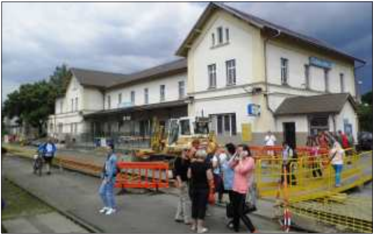
Stávající výpravní budova žst. Česká Lípa pocházející z roku 1892 prochází v rámci přestavby zdejšího uzlu rekonstrukcí za účelem montáže technologie nového zabezpečovacího zařízení a zřízení jednotného obslužného pracoviště.
