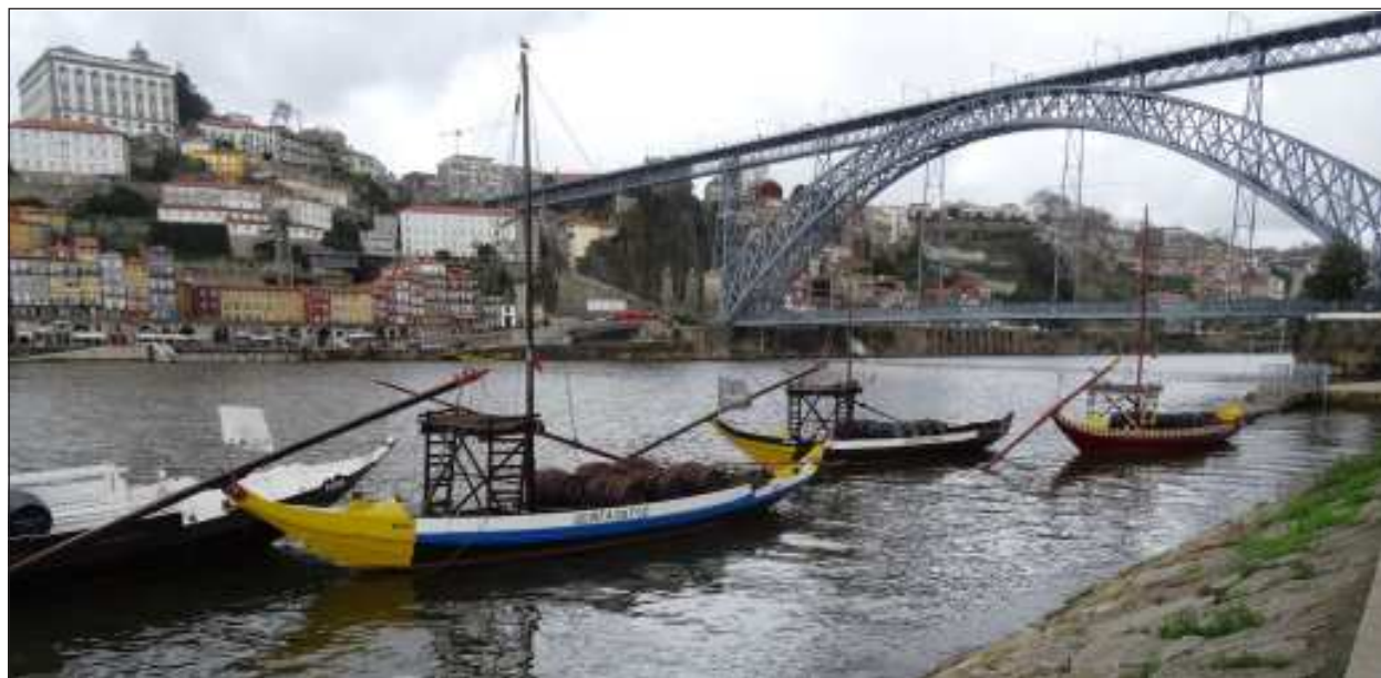
Typický obrázek z Porta, pořízený z nábřeží Cais de Gaia: řeka Douro a za ní nábřeží Cais da Ribeira, nahoře Episkopální palác s historickým centrem, napravo pak 44,6 m vysoký dvoupatrový most (dole jezdí auta, nahoře metro) Ponte de Dom Luís I., spojující historické centrum s Vila Nova de Gaia, částí proslavenou portským vínem.
