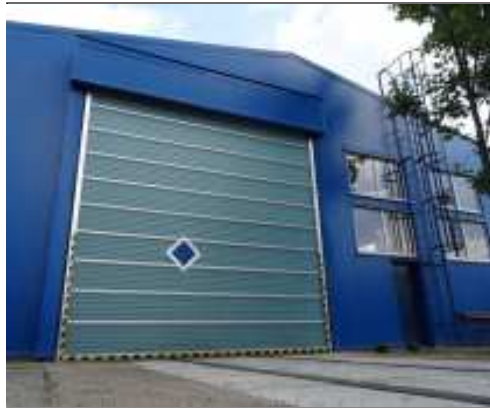
SOKV v Ústí nad Labem od loňského roku využívá nově zprůjezdněnou halu podúrovňového soustruhu H106.
