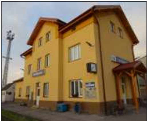
Budova žst. Lanškroun svítí novou fasádou.
