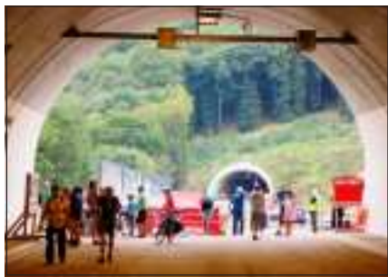
Pohled od jižního konce tunelu Radejčín k severním portálům tunelu Prackovice. Mezi oběma tunely překonává dálnice po mostě údolí Uhelné strouhy.
