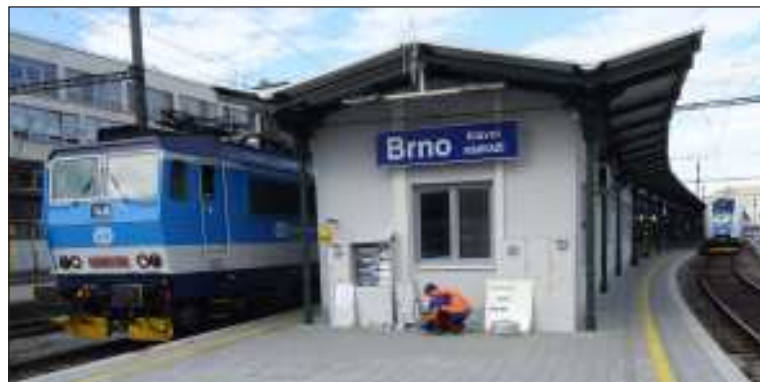
Po tříměsíčních opravách byly na brněnském hlavním nádraží uvedeny do provozu nástupiště č. 2 a 3. V průběhu oprav, spojených s výlukami těchto nástupišť, byl nahrazen dosavadní asfaltový povrch betonovou dlažbou, nevyhovující litinové sloupy byly nahrazeny přesnými replikami a nově jsou řešeny i informační a orientační tabule na nástupištech. Součástí oprav bylo i provedení tzv. antigrafitů nátěru. Více se o výluce na brněnském hlavním nádraží dočtete v článku na straně 3. Snímek Michael Mareš
