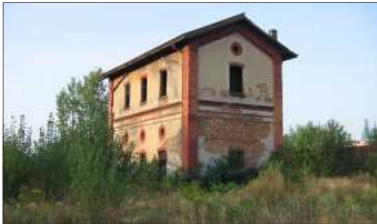
Poslední mohykán výtopny v Bubnech – vodárna StEG.
