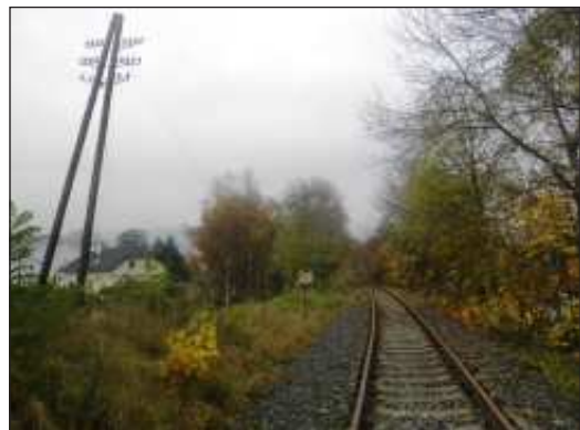
Železniční trať Děčín – Oldřichov u Duchcova se zavedenou dočasnou výlukou u Novosedlic v listopadu letošního roku. Vlevo zachovalý telegrafní sloup včetně drátů nadzemního vedení, což by zde bylo ideální dochovat pro případ zavedení turistických vlaků.
