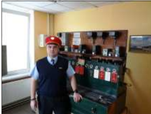
Ve směru na Liberec jsou jízdy vlaků zajišťovány elektro-mechanickým zabezpečovacím zařízením.
