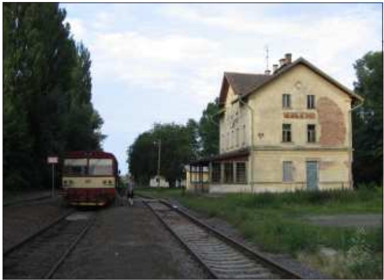
Vlak Os 17717 s odjezdem z Císté 19.57 h, 17. 7., motorový vůz 810.644-5, staniční budova SŽDC je vyklizena, ač o ni mělo zájem město, zůstává prázdná, okna i dveře jsou zazdýněny.
