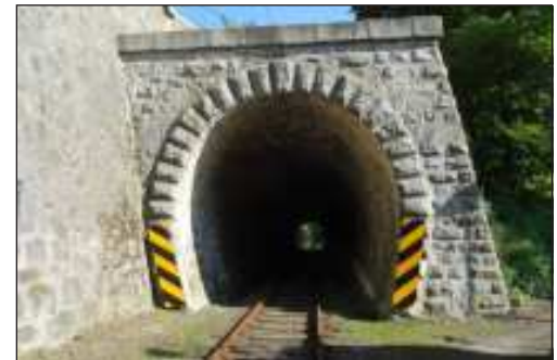
Tunel pod Loktem.
