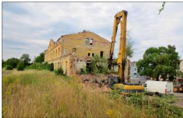
Mohutné ocelové nůžky se co nevidět s „chutí“ pustí do drčení zdiva starého nádraží v Duchcově.
