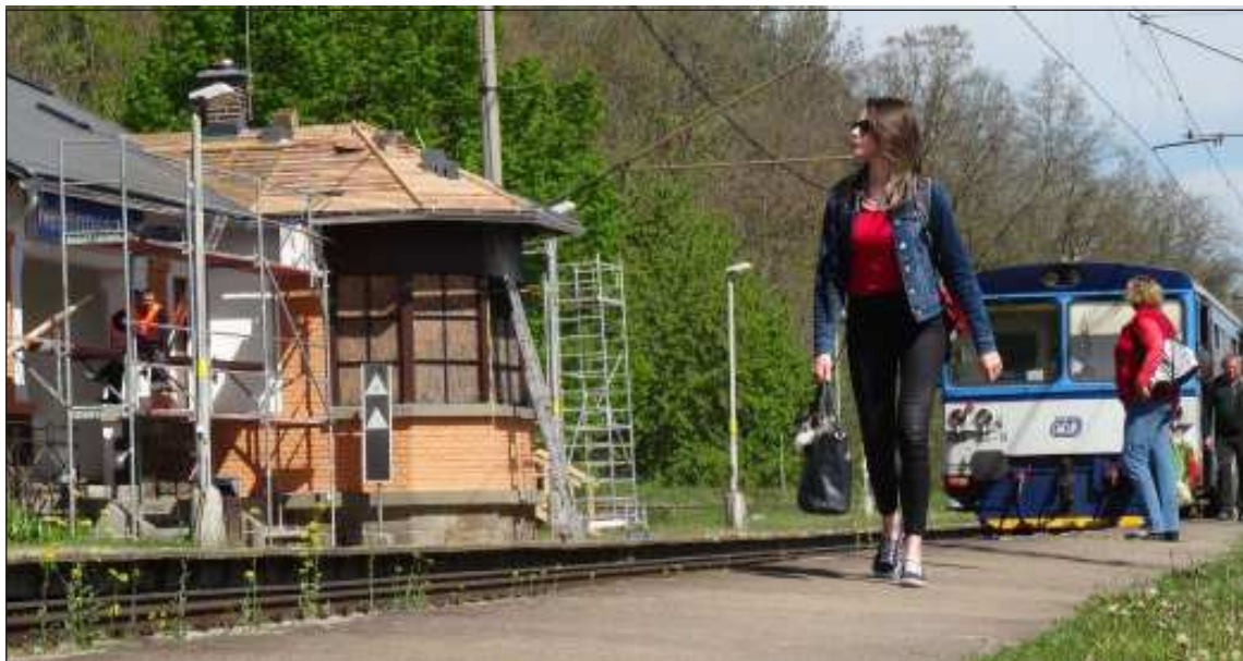
Správa železniční dopravní cesty předala do užívání opravenou výpravní budovu žst. Nelahozeves. V současné době je těsně před dokončením také oprava sousední zastávky u nelahozeveské vjezdové vjezdové. Vzhledem k jejímu turistickému potenciálu hodlá tamní radnice využít část opravených prostor jako infocentrum obce. Snímek Michael Mareš
