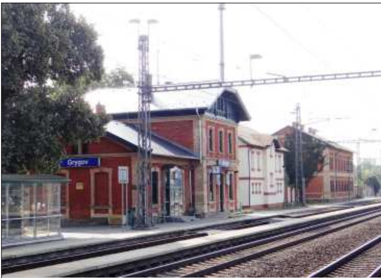
Současná podoba železniční stanice Grygov – zleva výpravní budova s podchodem, technologická budova a bytové domy.
