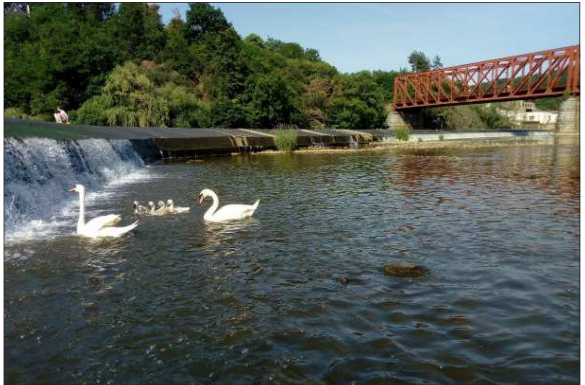
U železničního mostu a jezu na řece Berounce u Mokropes (trati 171) vyváděly labutě své nedávno vyhlédlé mladé. Most má být prý v nedaleké budoucnosti nahrazen novým, ač byl nedávno rekonstruován. Snímek Martin Kubík
