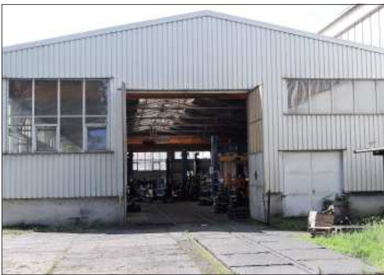
Celkový pohled na halu C, kde probíhá oprava podvozků.
