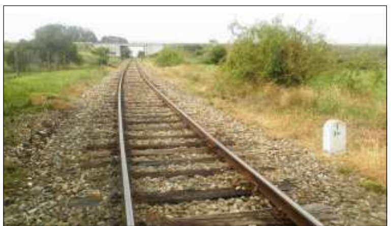
Současná vlečka 5298 Vranovice – Pohořelice v km 1,0 za Vranovicemi (stav ze dne 22. 8. 2019), kde se nachází torzo telegrafního sloupu, v pozadí je silniční nadjezd ze silnice II/381 (přivaděč na dálnici D52), odkud je pěkný výhled na jihomoravskou krajinu, zejména na CHKO Pálavské vrchy.
