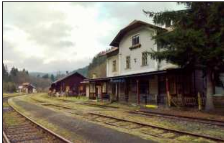
Budovy v Rokytnici (na snímku) i v Hrabachově jsou v ohrožení, nejvyšší čas je nějak chránit.
