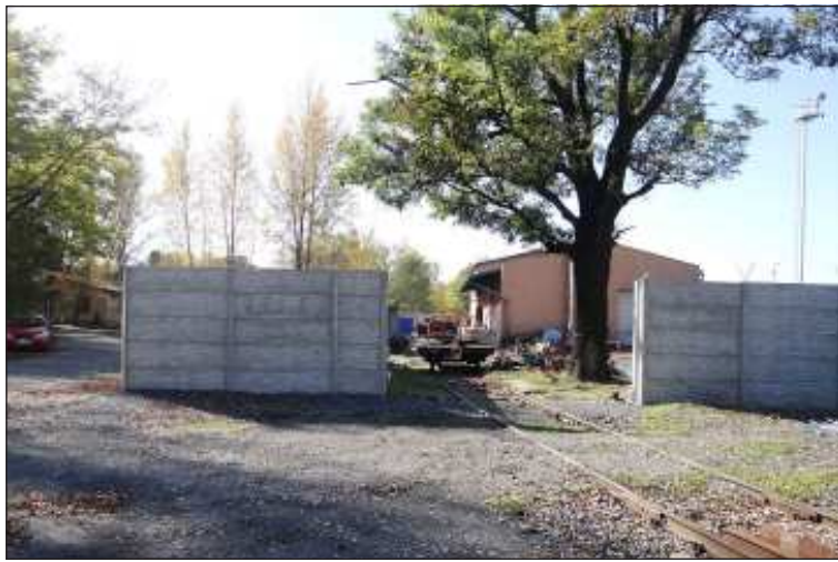
Areál TO Bohumín s novým betonovým plotem.
