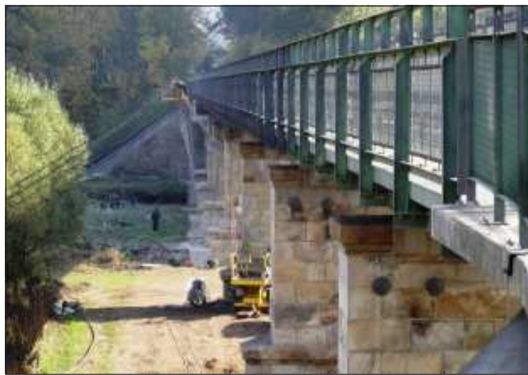
Letos na podzim byl 160 let starý most opravován. Mimo jiné došlo k očištění spodní stavby, k odstranění náletových dřevin v okolí mostu i k otryskání ocelové konstrukce a provedení protikorozní ochrany mostu včetně jednovrstvého nátěru lávky.
