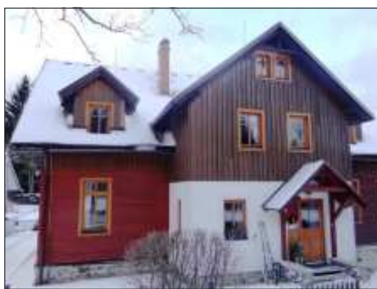
Penzion Pacifik sloužil původně jako obecná škola.
