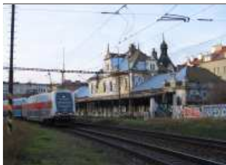
Stav nové zápatované střechy na budově bývalého nádraží Praha-Vyšehrad, 27. 12. 2017 kolem 15.10 hodin, jeden z vlaků příměstské linky S7.
