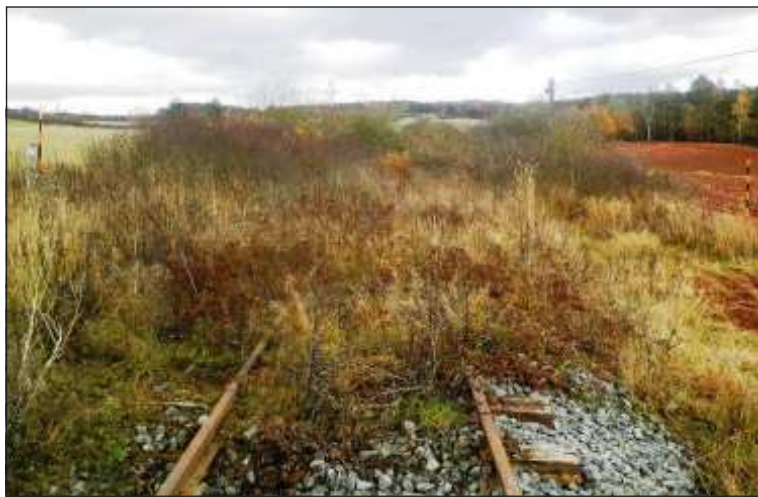
Obec Mladotice má zájem o obnovu zarostlé lokální tratě z Mladotic do Kralovic v délce 11,345 km. Smlouvu o bezplatný převod do svého vlastnictví však odmítá podepsat, neboť zjistí uje možnosti získání dotace na její obnovu ze Státního fondu dopravní infrastruktury. Nejlevnější by oprava tratě přišla na zhruba 90 milionů Kč.
