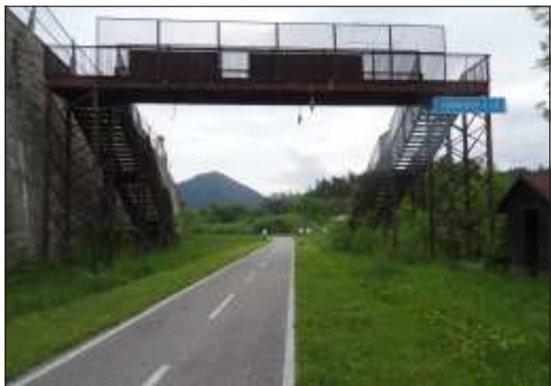
Pozůstatky bývalé stanice Tarvisio Centrale.
