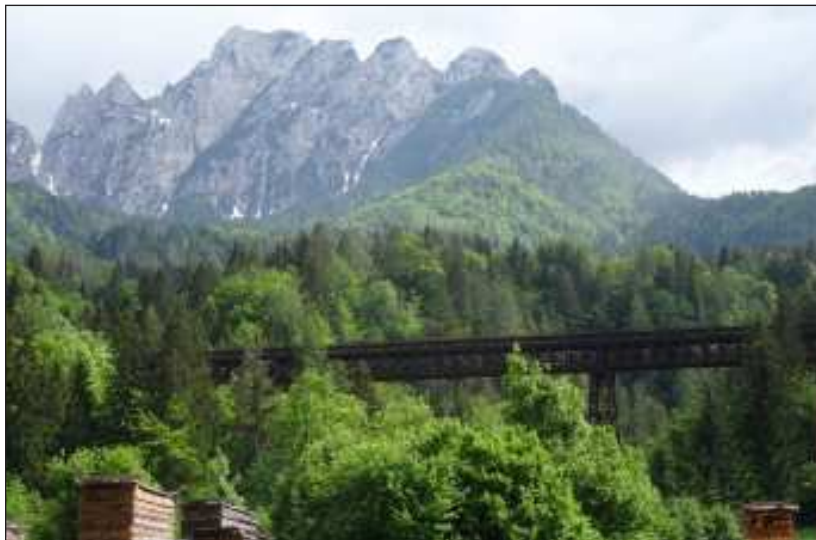
Cyklistická stezka D–2 nyní vede po podstatné části původní železniční trati. Na trase cyklostezky se dodnes nachází mnoho bývalých drážních objektů, mimo jiné i tento nádherný most.
