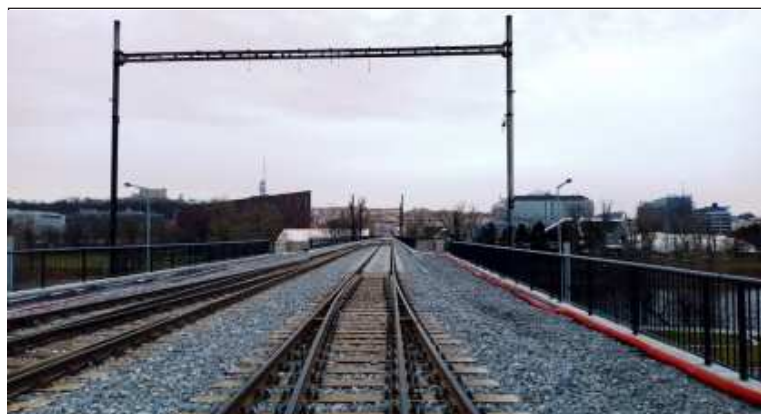
Nové koleje a výhybky na pražském Negrelliho viaduktu byly již položeny, začíná montáž sloupů trolejového vedení, dle harmonogramu prací by měla být výluka ukončena v červnu letošního roku. Celá stavba by měla být dokončena až v roce 2021 ( http://www.rekonstrukce-negrelliho-viaduktu.cz ).
