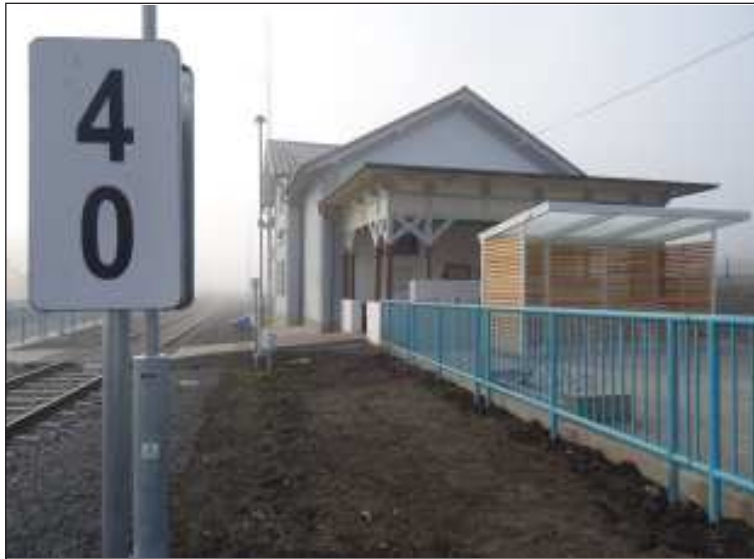
Budova čížkovického nádraží byla vloni rekonstruována a slouží pouze jako zázemí pro technologii, veřejnosti je k dispozici boční dřevěný přístřešek pro kola.
