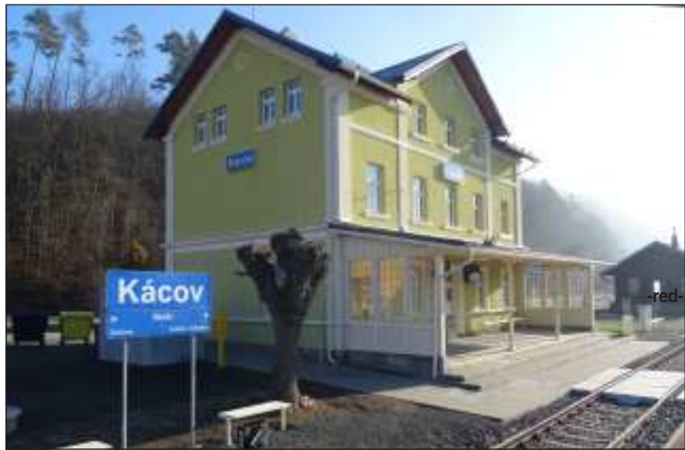
Výpravní budova ve stanici Kácov září novotou, došlo k opravě fasády a střechy, jsou zde i nová okna a dveře. Pro cestující je k dispozici nová čekárna a pro zaměstnance opravené prostory dopravní kanceláře s potřebným zázemím. V Kácově je také nový vnitřní i venkovní mobilniál, zpevněné plochy kolem budovy byly rovněž upraveny. Původní dřevěné WC zde nahradily nové mobilní toalety se zástěnou z tahokovu. Ve stanici se také mimo jiné vyměnili železniční svršek ve dvou staničních kolejkách, opravilo se šest výhybek a nástupiště. Oprava výpravní budovy v Kácově stála 7,1 milionu korun, slavnostní otevření proběhlo v listopadu 2019.
