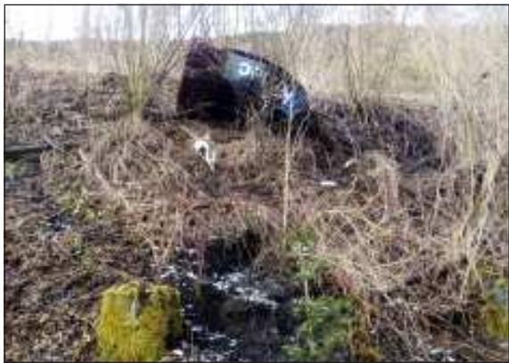
Přístřešek zastávky Klíneck, svržený do údolí Bojovského potoka. Ne, nejsme v bojové linii v Bosně 90. let, ale v klidném Česku pod dobrou Správou železnic, hlavně, že úředníci fotí, co by kde zbořili, v tomto případě to za ně udělala vyšší moc!
