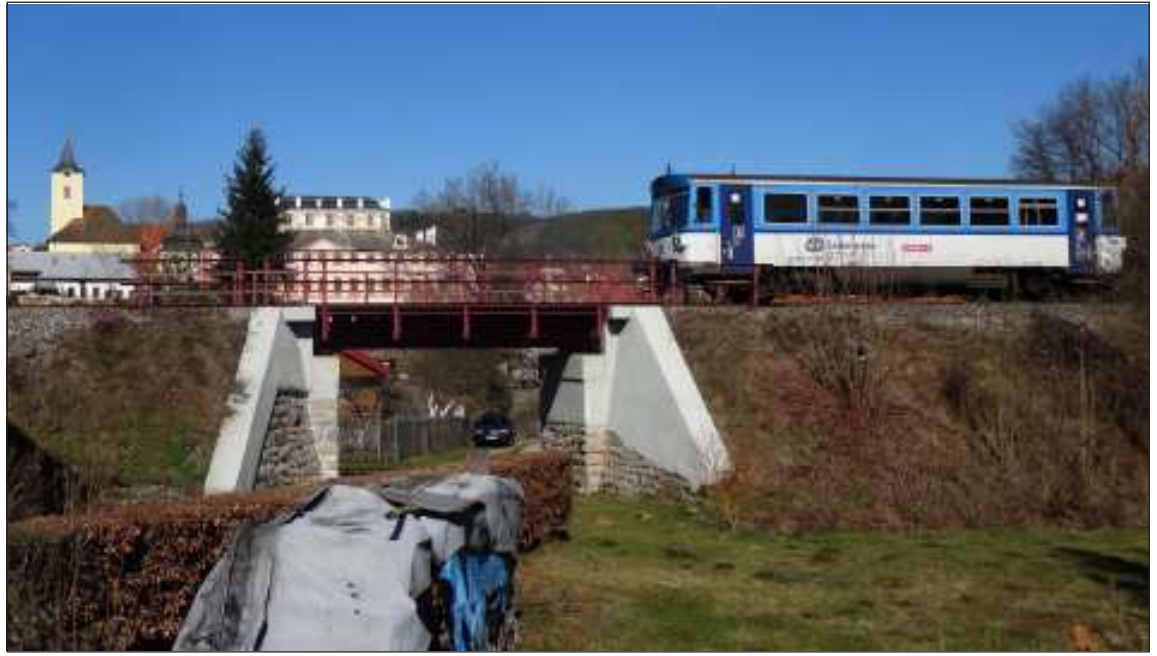
Vloni v červnu ukončila Správa železnic (SŽDC) opravu části Posázavského Pacifiku mezi Ledečkem a Zručí nad Sázavou. Během ní proběhla sanace přibližně 30 kilometrů tratě včetně železničního svršku i spodku. Na snímku Michaela Mareše osobní vlak 9215 jedoucí po opraveném úseku poblíž zastávky Kácov, v pozadí kácovský zámek a kostel Narození Panny Marie.
