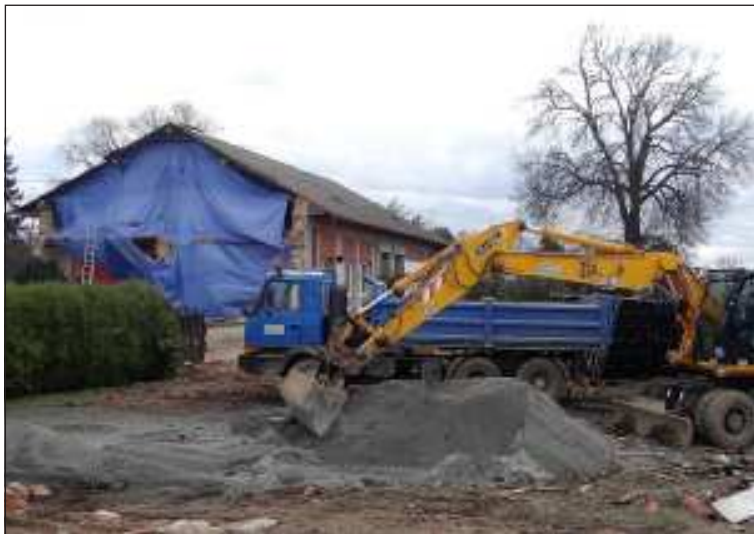
Staniční budova zůstane zachována, služební byt, s ní spojený, byl ovšem zbourán.
