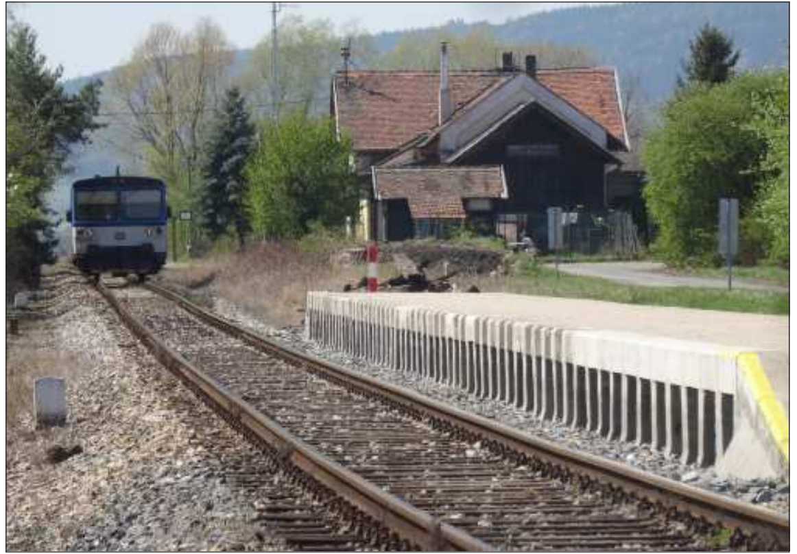
Podle platného jízdního řádu 2019/2020 zajíždí do Osova v pracovních dnech devět párů vlaků denně a každý z těchto vlaků projíždí kolem rozestavěné nové zastávky u přejezdu P588 na silnici z Osova do Dobříše. Pro mnohé řidiče je překvapením, zejména u vlaků jedoucích ve směru od Lochovic, že vlak v zastávce nezastaví. Občas se tak stane, že strojvedoucímu motorového vozu řady 810 projede auto těsně před vlakem. Na snímku osobní vlak 27711 z Lochovic do Zadní Třeboané projíždí kolem nové zastávky. Více informací na straně 2.
