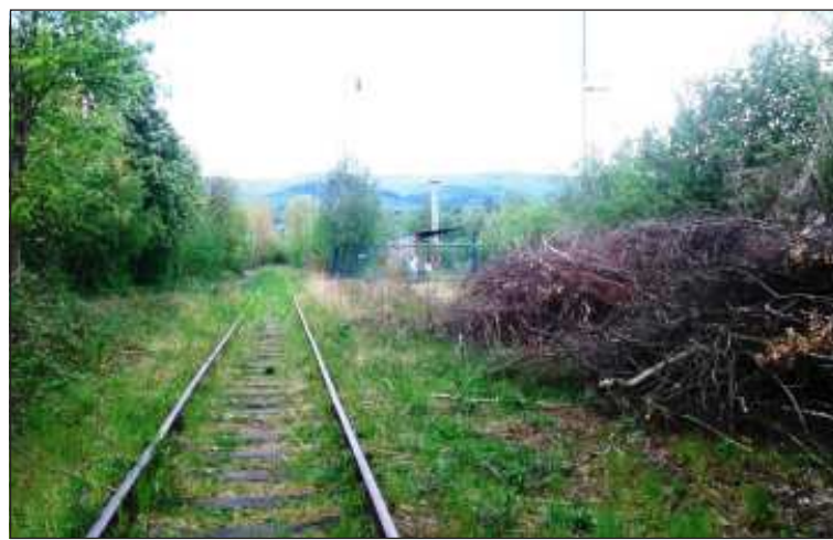
V traťovém úseku Telnice – Oldřichov u Duchcova (na snímku u Novosedlic) nedávno proběhla likvidace náletové vegetace za účelem lepší kontroly traťového svršku. Vpravo kdysi vedla vlečka do Novosedlické teplárny, jež odbočovala ze širé tratě.
