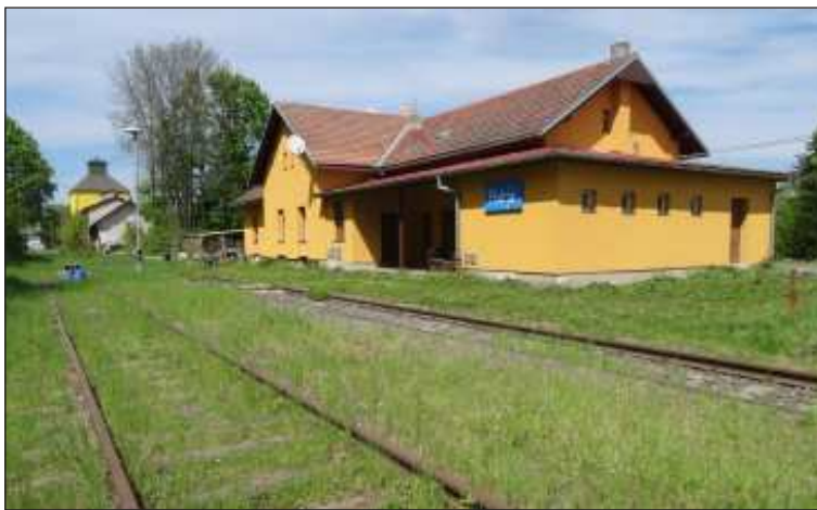
Koncové nádraží v Polné leží stranou centra města, Správa železnic nechala objekt nádraží nedávno opravit.
