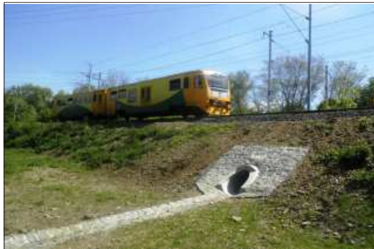
V loňském roce byla provedena elektrizace a optimalizace regionální trati 132 Kadaň–Prunéřov – Kadaň, ovšem vzhledem k absenci střídavých či dvousystémových elektrických jednotek v Ústeckém kraji je zde osobní doprava stále vedena v motorové trakti. Na snímku ze dne 19. 5. 2020 přejíždí osobní vlak ČD relace Kadaň–Prunéřov – Kadaň rekonstruovaný propustek před vjezdovým návěstidlem do žst. Kadaň.
