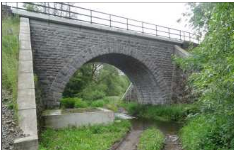
Historická jímka pod kamenným viaduktem v km 16,9.
