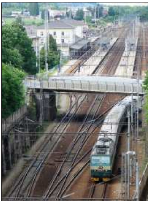
S výstavbou Olomoucko–pražské dráhy se začalo v Chocni, v místě, kde trať prochází nejnáročnějším terémem. S ražením dvoukolejného tunelu se začalo v roce 1843. Dnes již zde tunel nenajdeme, koncem čtyřicátých let minulého století byl při rozšiřování choceňského nádraží snesen a nahrazen hlubokým zájezdem.
