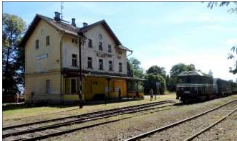
Dopravná D3 Čistá. Pokud se změni na D1, změni se i odbočná kolej (vpravo) na manipulační. Není to tak dlouho, kdy se v Čistě pravidelně křižovalo, byl zde komerční pracovní a budova byla obydlena, nyní je prázdná, město Čistá o ni prý má zájem, tak snad nepadne. Stav 1.8. odpoledne – zvláštní historický vlak relace Kralovice – Rakovník – Lužná T 435.0139.
