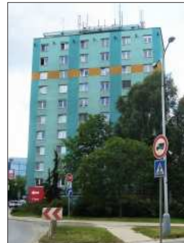
Brněnský dům hrůzy opět slouží nájemníkům.
