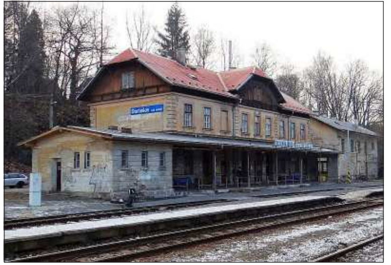
Původní budova domašovského nádraží údajně čeká drastickou revizi jejího současného vzhledu.
