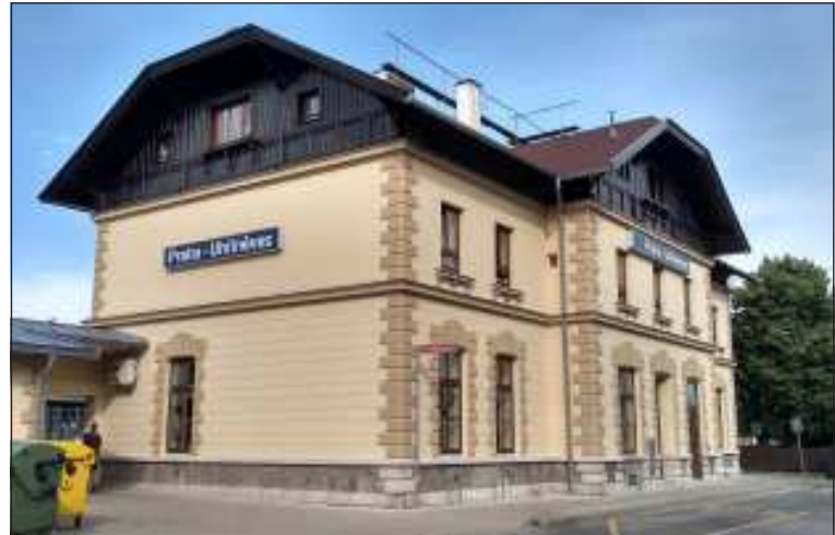
Krásně opravená výpravní budova v Praze-Uhřetěvesi.
