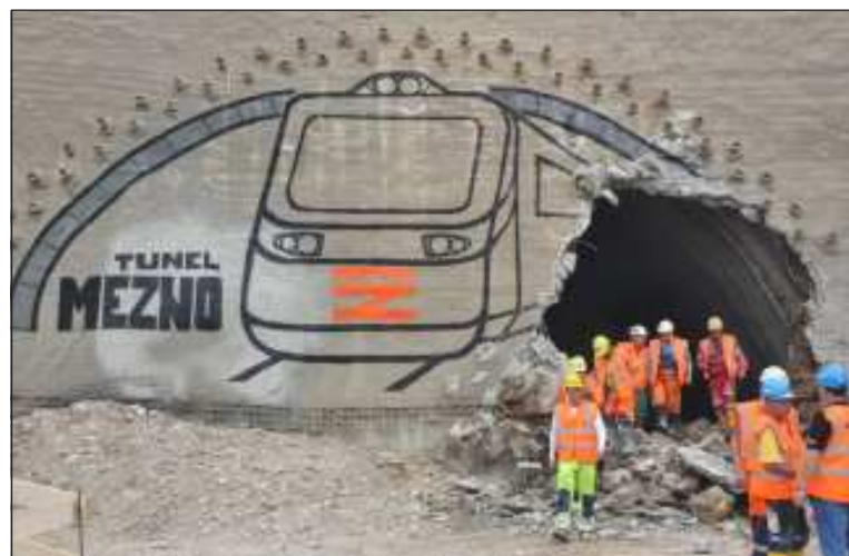
Pracovníci OHL ŽS po slavnostní prorážce vycházejí z tunelu Mezno.
