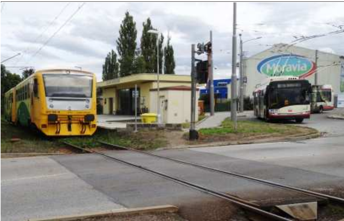
Ke zlepšení propojení jednotlivých forem dopravy prostřednictvím dopravního terminálu pro přestup mezi osobní vlakovou a městskou hromadnou dopravou došlo vloni v Jihlavě. Dopravní terminál u vlakové zastávky Jihlava – Staré Hory (225) je vzorovou ukázkou propojení vlakové a městské hromadné dopravy, v tomto případě vlaku s trolejbusem. Na snímku M. Mareše osobní vlak 18417 z Jihlavy do Tábora.
