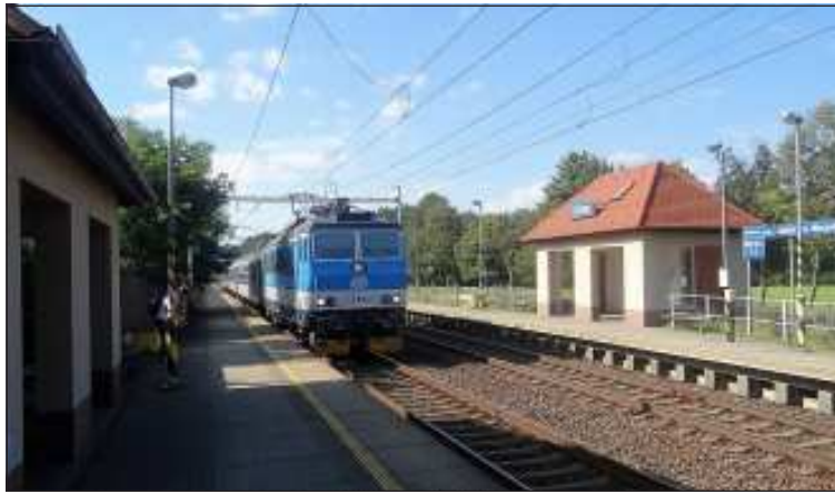
V současné době zastavují vlaky osobní dopravy u nově postavené zastávky. Ta dosud úspěšně odolává nájezdům vandalů.
