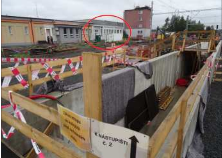
Část výpravní budovy již byla zbourána (označeno kroužkem).
