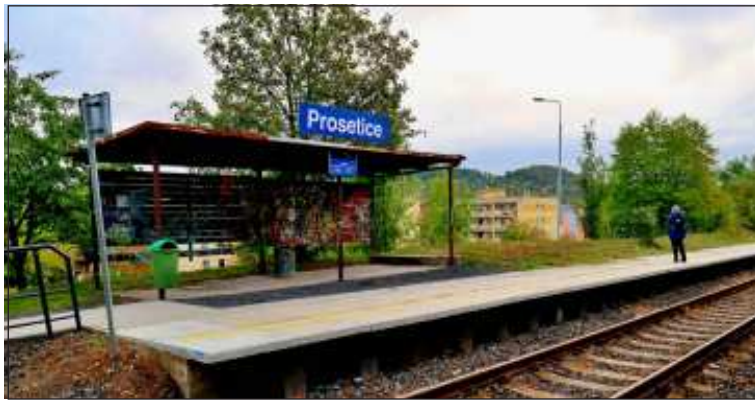
Pohled na opravený prostor zastávky Prosetice s novou nástupní hranou. Vadou na kráse je chybějící cca 5 metrů chodníku od přechodu k nástupišti.
