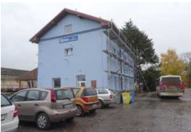
Většina fasády železniční stanice Ždírec nad Doubravou byla na konci října již v novém slušivém modrém kabátu.
