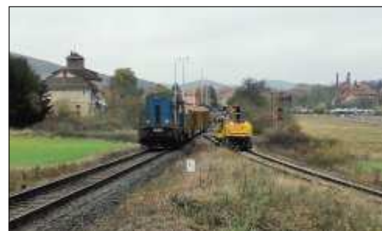
Pracovní vlak se štěrkem vede lok. 740.748-9 a mechanismus firmy STRABAG u úvratě Liteň, 11. 11. krátce před 11. hodinou na svátek sv. Martina.
