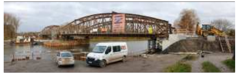
V rámci modernizace a optimalizace traťového úseku Lysá nad Labem – Čelákovice probíhá kompletní rekonstrukce dvoukolejného mostu přes Labe v Čelákovicích.
