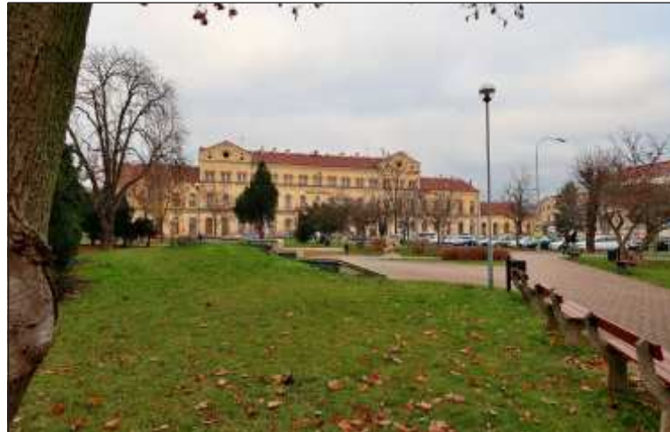
Nádražní budova v Teplicích v Čechách z roku 1871 patří i dnes k nejhonosnějším objektům ve městě. Pohled na nádraží z parku Milady Horákové.
