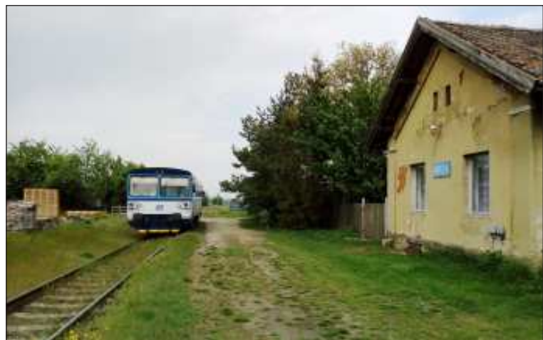
Zrušené nákladíště a zrušená zastávka Bříza (nezaměňovat s Břízou obec, ta se původně jmenovala Račíněves na trati Straškov – Libochovice) ležela na trati Straškov – Zlonice, jejím zrušením odstartovalo odpočítávání konce pravidelné dopravy. Protože z Břízy dojížděli dělníci do místní pily v obvodu bývalé zastávky, pak předsedali nuceně na auta. I tak se dají vyhnat lidé z vlaků! Foto ze 7. 5. 2019 – více v rubrice Cestujeme s Obzorem (www.osz.org) z 22. 5. 2019.
