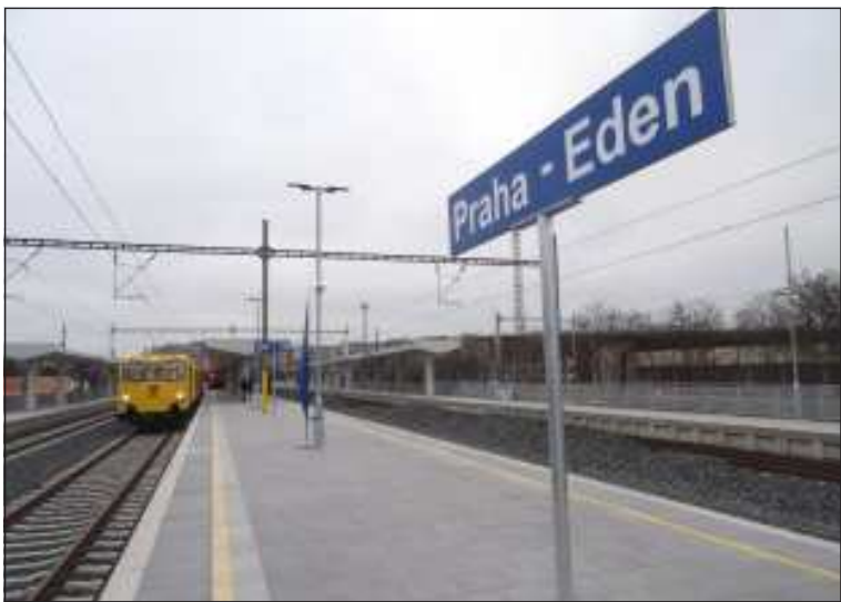
V neděli 13. 12. 2020, souběžně se začátkem platnosti jízdního řádu pro rok 2021, byla po dlouhých devíti letech v Praze otevřena nová zastávka Praha-Eden.
