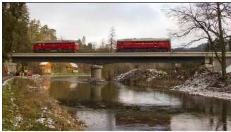
Sergejové na novém mostě přes Sázavu ve Vlastějovicích.
