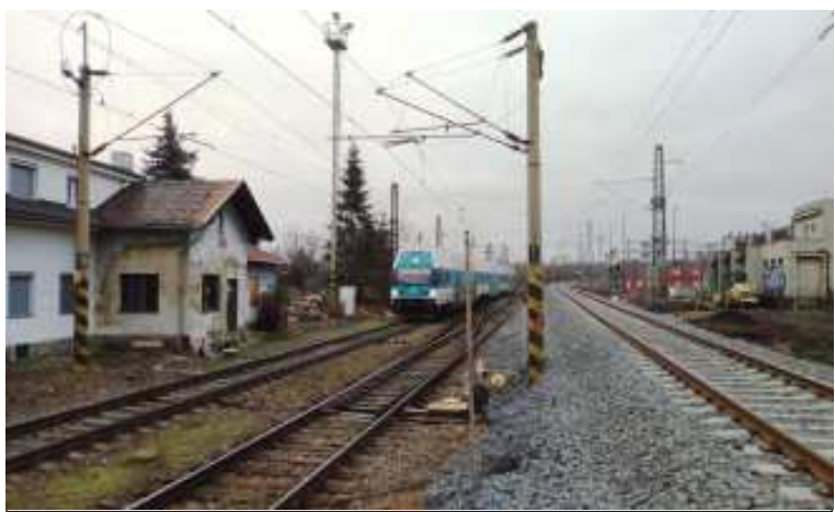
Bývalá odbočka Záběhllice, po trati vlevo se již nikdo nesveze, vpravo nová trať, v tomto úseku bude až do ukončení rekonstrukce a snesení staré tratě jednokolejná. Stav 12. 12. 2020 v pozdním odpolední.
