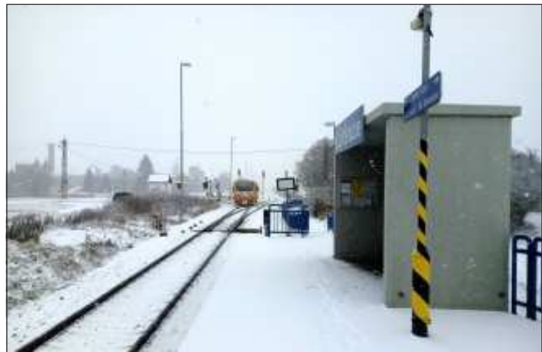
Nová zastávka Luštěnice v obvodu žst. Luštěnice – Újezd (přejmenována kvůli nové z Luštěnice) u PZZ. Typický objekt bez jakéhokoli zázemí, v zimě vírholec pro otužilce, 12. 1., 11.23 h, Os 6044 s cílem Mladá Boleslav město.
