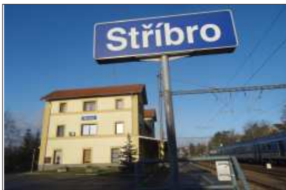
Modernizace železniční stanice Stříbro byla ukončena v roce 2009.
