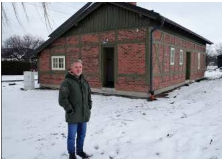
Starosta obce Úvalno Radek Šimek před opravovanou budovou zastávky, která přešla do majetku obce.
