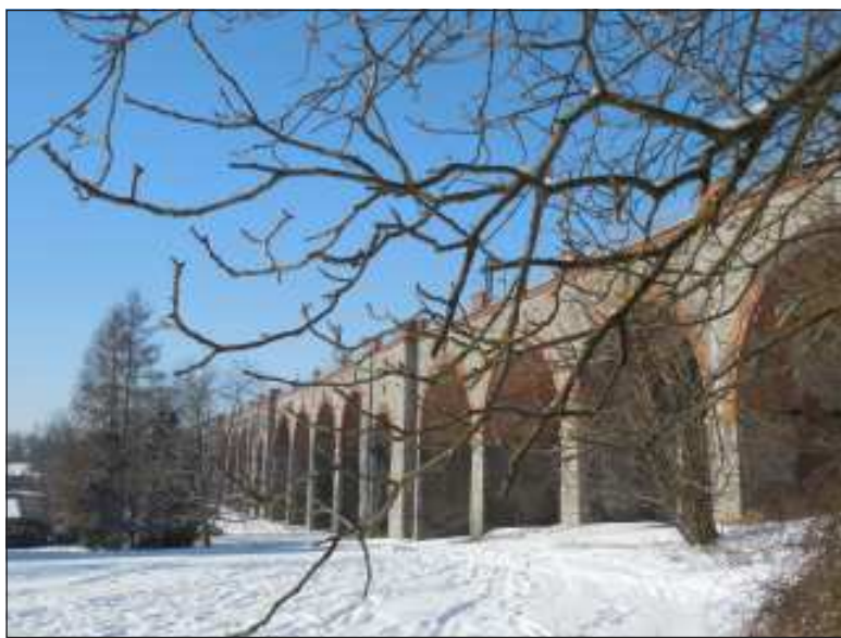
Hranické viadukty byly v roce 2007 prohlášeny kulturní památkou.
