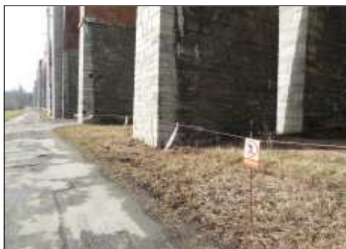
V únoru 2021 nechala Správa železnic cihlové viadukty opáskovat.
