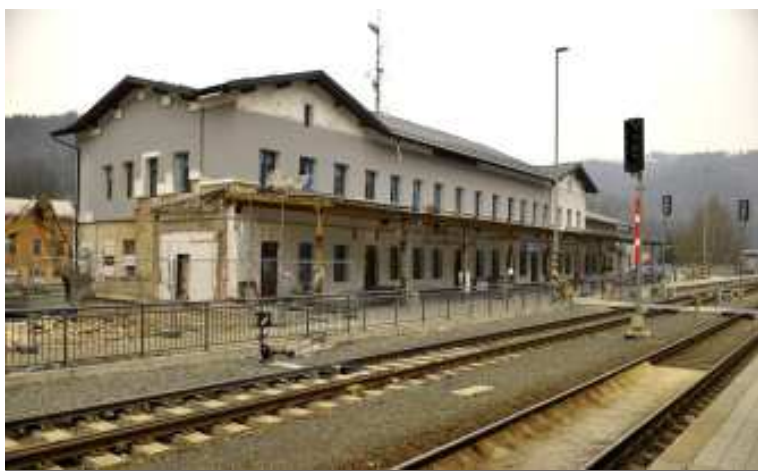
V Hanušovicích probíhá celková rekonstrukce výpravní budovy.
