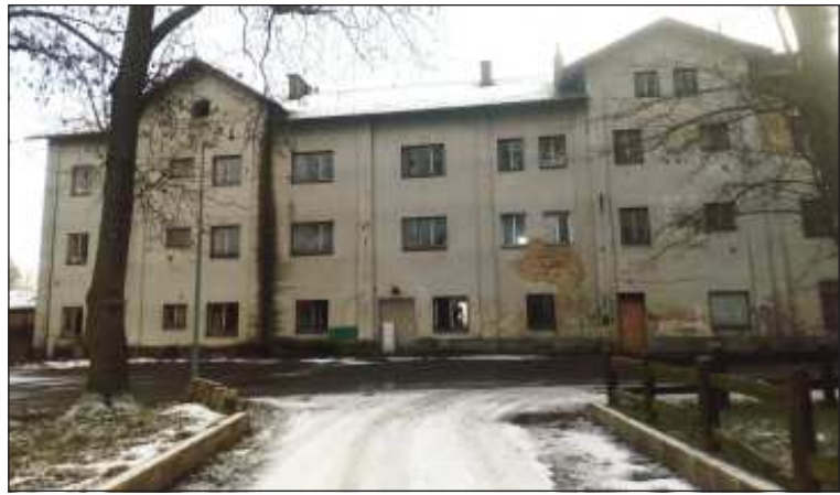
Zadní partie opuštěné výpravní budovy žst Chotětov, stav 25. 1.
