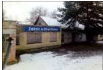
Bývalá žst. a přípojová žst. vlečky do Benátek nad Jizerou, Zdětín u Chotětova (km 57,362), je po zrušení výpravního a následně i závoráře zcela opuštěná. Vlečka mohla být využívána pro osobní dopravu příměstského typu – vedla přímo do centra města, místo ní je tam další módní cyklostezka.
