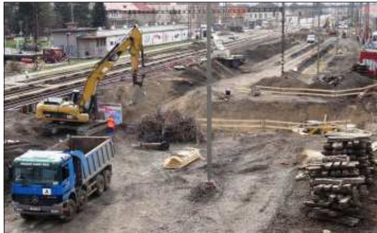
Čilý stavební ruch lze pozorovat při stavbě sudé skupiny, v jejímž rámci probíhá komplexní přestavba podchodu.
