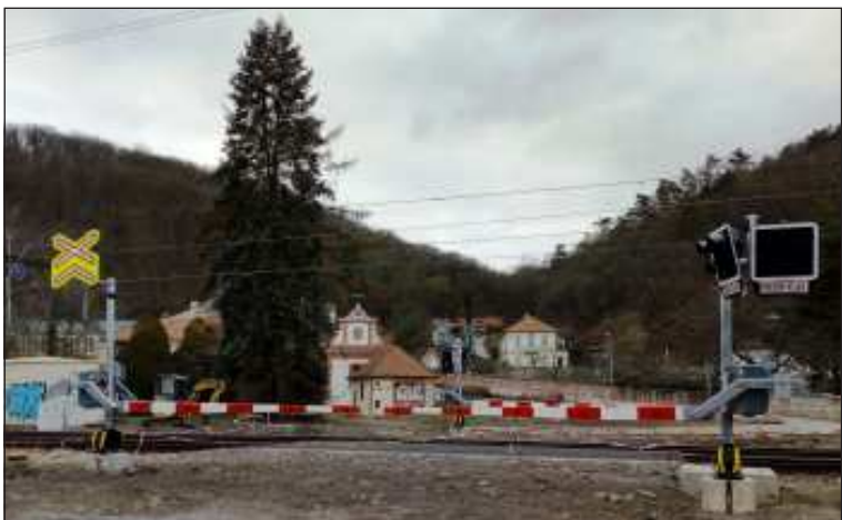
Nové PZS v místě bývalého PZM a před 34 lety sneseného hradla Malá Chuchle, v pozadí bývalé lázně a kostel Malá Chuchle, druhý majetek zbraslavského kláštera zrušeného již Josefem II.
