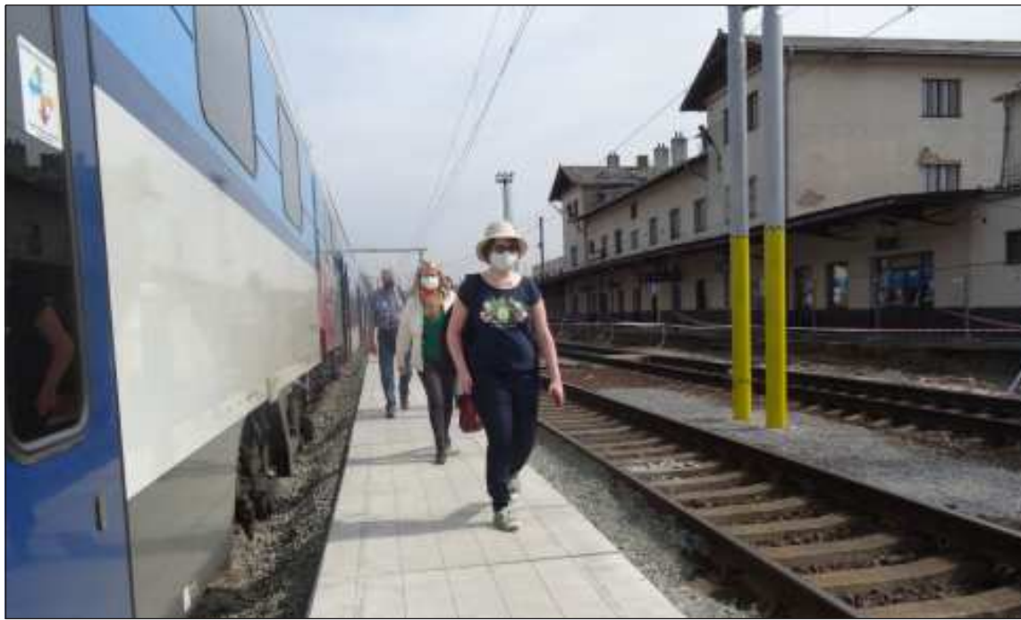
Adieu, Vysočany! V pondělí 12. dubna byla zahájena demolice pražského vysočanského nádraží. Na snímku Michaela Mareše z 1. 4. 2021 je ještě zachyceno nádraží těsně před zahájením demoličních prací. Cestujícím nyní slouží provizorní nástupiště, přístřešky a osobní pokladna.
