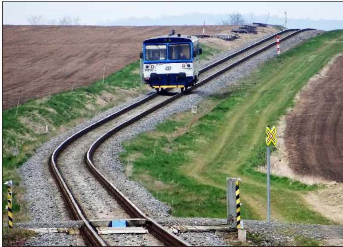
Jako na tobogánu vypadá jízda osobního vlaku na trati Červenka – Prostějov hl. n. Ve skutečnosti trať vede úrodnou hanáckou rovínou – na snímku se vlak blíží k zastávce Cholína. Původní budova této zastávky byla před několika málo lety srovnána se zemí, podobně jako mnoho jiných železničních budov. O jejich možné zachráně pojednává rubrika „Představujeme“ na 2. straně tohoto čísla. Snímek Miroslav Časlavský
