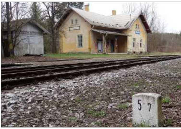
Železniční stanice Mladeč je koncovou stanicí na trati 308 z Litvle-předměstí.
