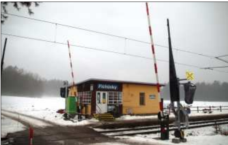
Střídání strážů u přejezdu, tak by se mohl nazvat snímek pořízený na konci února v Plichůvkách, kdy ještě sloužily mechanické závorý obsluhované závoráři a zároveň už vedle nich čekaly na spuštění nové automatické závorý.
