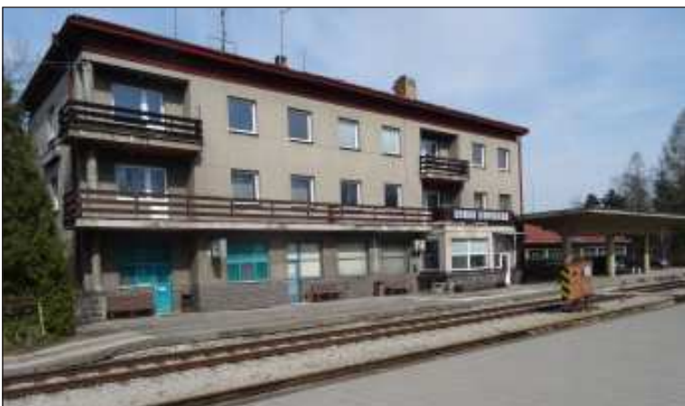
Objekt nádraží ve Velkém Meziříčí z roku 1953 byl postaven ve funkcionalistickém slohu.
