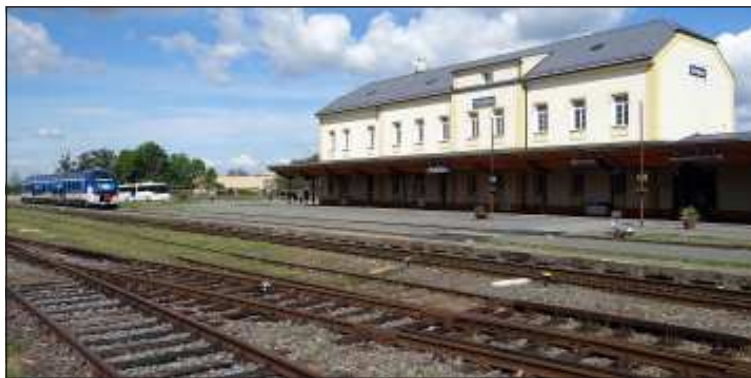
Holešovská nádražní budova v současné podobě (přestavěna byla v roce 1949, opravená v roce 2011) zřejmě zůstane zachována, kolejště však bude redukováno.
