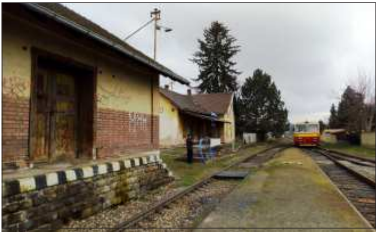
Os 18341, 17. dubna v pravé poledne zastavuje v dopravně D3 Budyně nad Ohří, dopravce KŽC motor M 152.0656, v popředí stavební činnost na obnově PZS, dirigující dispečer sídlí v žst. Straškov, nebylo by od věci zřídit jednokolejnou dopravnu v zastávce Bríza obec, tím by se zvýšila propustnost tratě, takto se nedá sestavit smysluplný jízdní řád a připoje mezi ČD a KŽC v Straškově uždějí! Správa železnic by se měla zamyslet.
