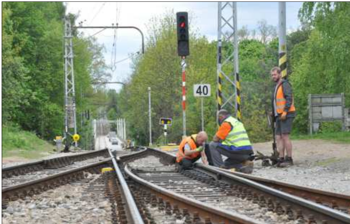
V pátek 21. 5. 2021 bylo v Bechyni rušno, v 15 hodin zde byla za plného provozu aktivována „JOPKa“. Elektromechanika v Bechyni tak po padesáti letech končí, nahradily ji počítače a monitory od firmy Starmon. Na snímku Michaela Mareše poslední úpravy před spuštěním, v pozadí bechyňská Duha, unikátní železobetonový obloukový most z roku 1928 přes řeku Lužnici.
